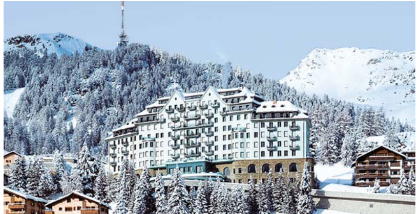
Im 5-Sterne-Hotel Ritz Carlton in St. Moritz wird das Abwasser zur Wärmegewinnung genutzt.
