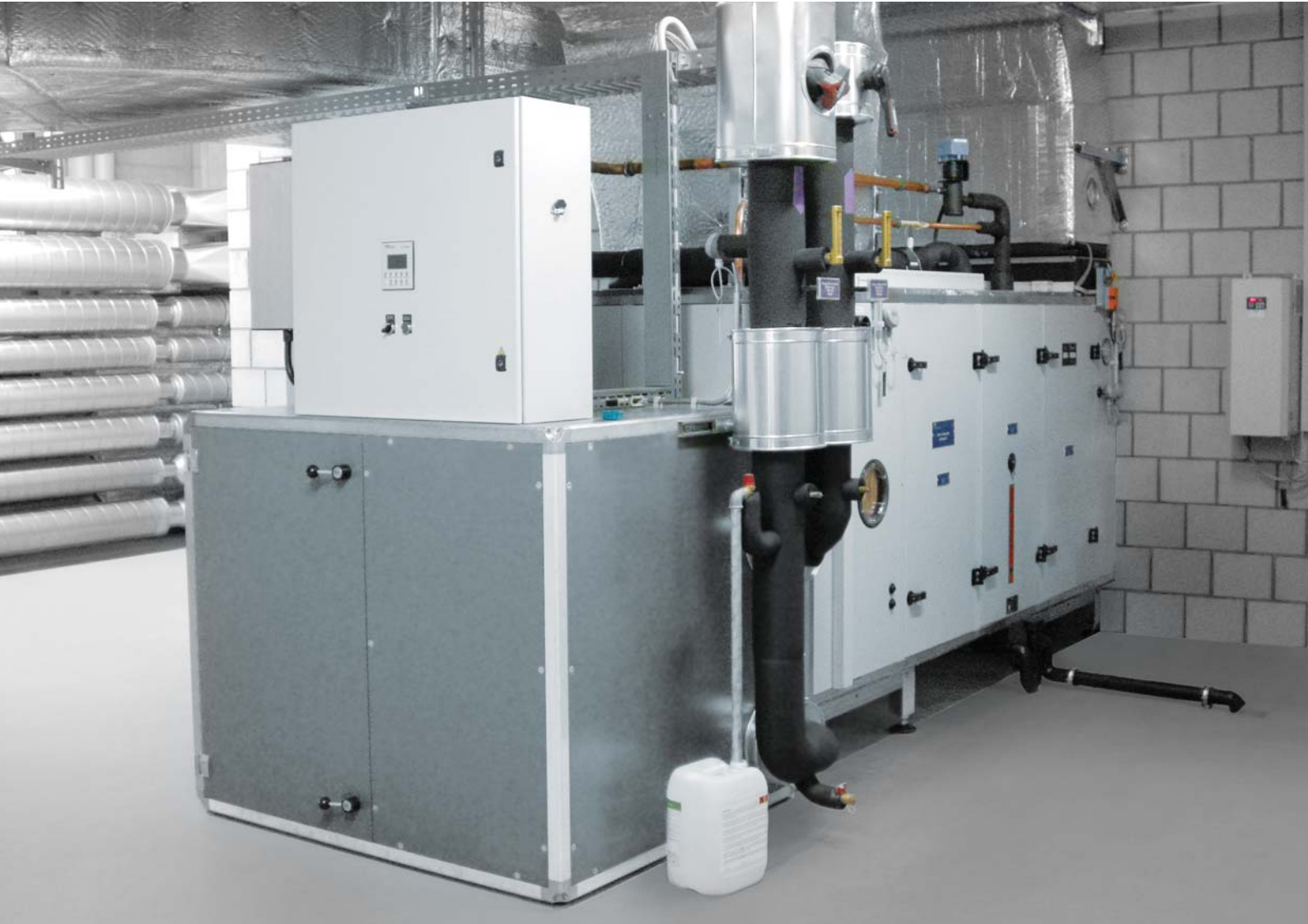
Luft/Wasser-Wärmepumpe
