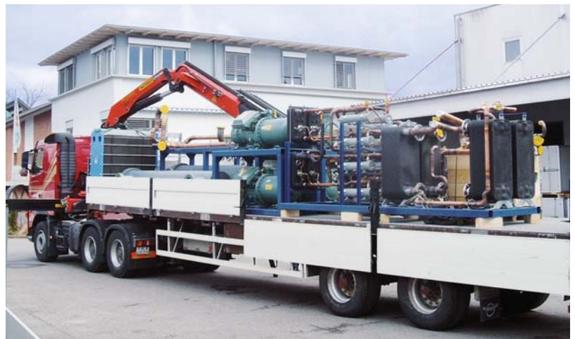
Abhängig von der Einbringsituation werden Viessmann Wärmepumpen in Modulen geliefert.
