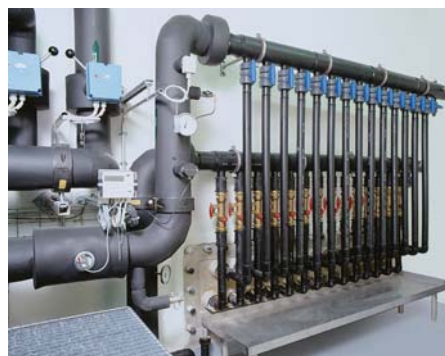
Erdsondenverteiler
