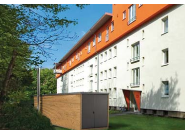
Mit einer Lamellenverkleidung lassen sich die Container ansprechend am Aufstellort integrieren.
