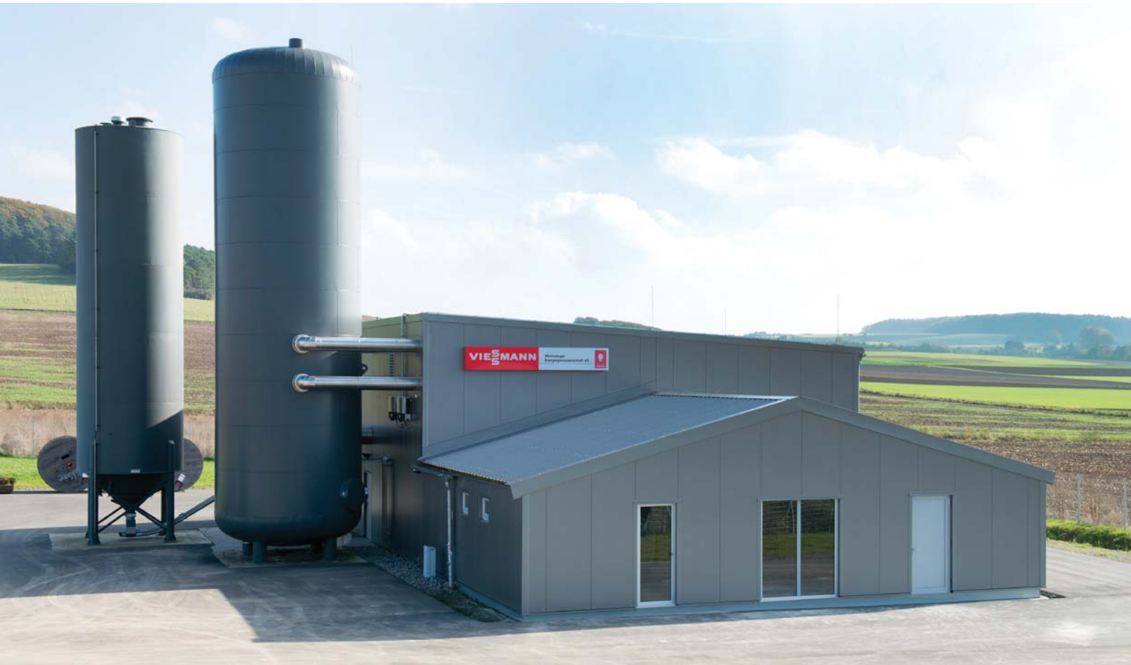
Biomasseheizwerk mit drei Vitoflex Pelletkesseln in Wettessingen bei Kassel
