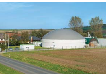
Diese Biogasanlage wird von der Bioenergie Wettelingen betrieben.
