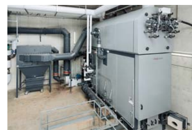
Biomassekessel Vitoflex 300-SRT mit einer Leistung von 1 MW
