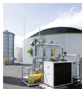
Biogasanlage zur Nassfermentation
