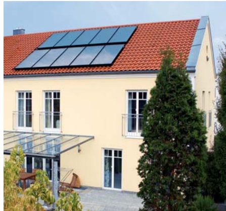
Vitosol 200-FM Zweifamilienhaus Geisenfeld
