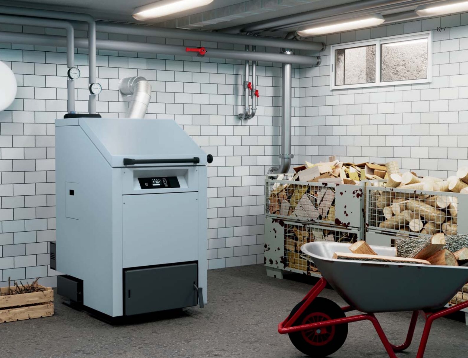
Scheitholz-Vergaserkessel Vitoligno 300-S – manuell von oben beschickbar
