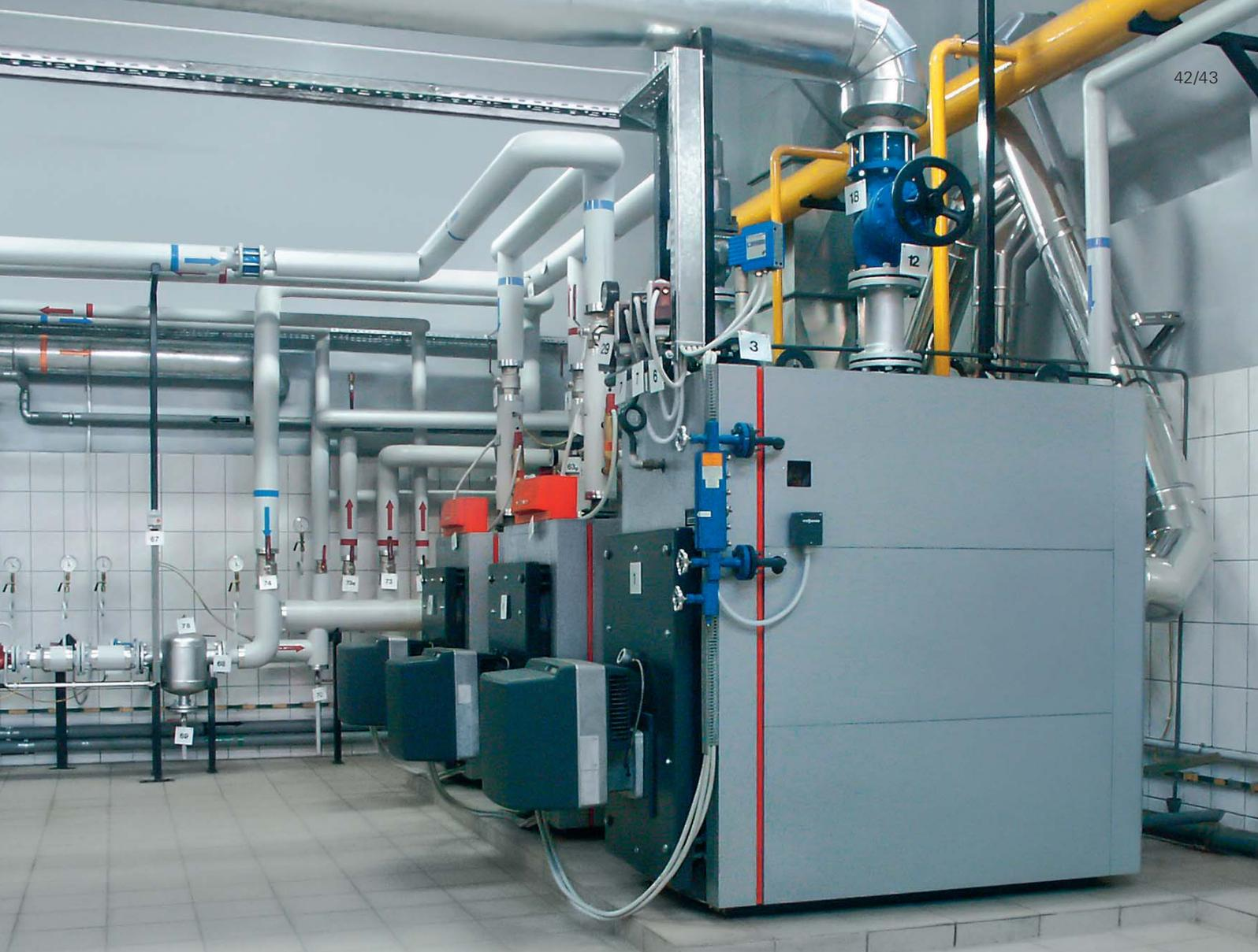
Anlage mit einem Vitoplex LS Niederdruck-Dampferzeuger sowie zwei Vitoplex Heißwassererzeugern
