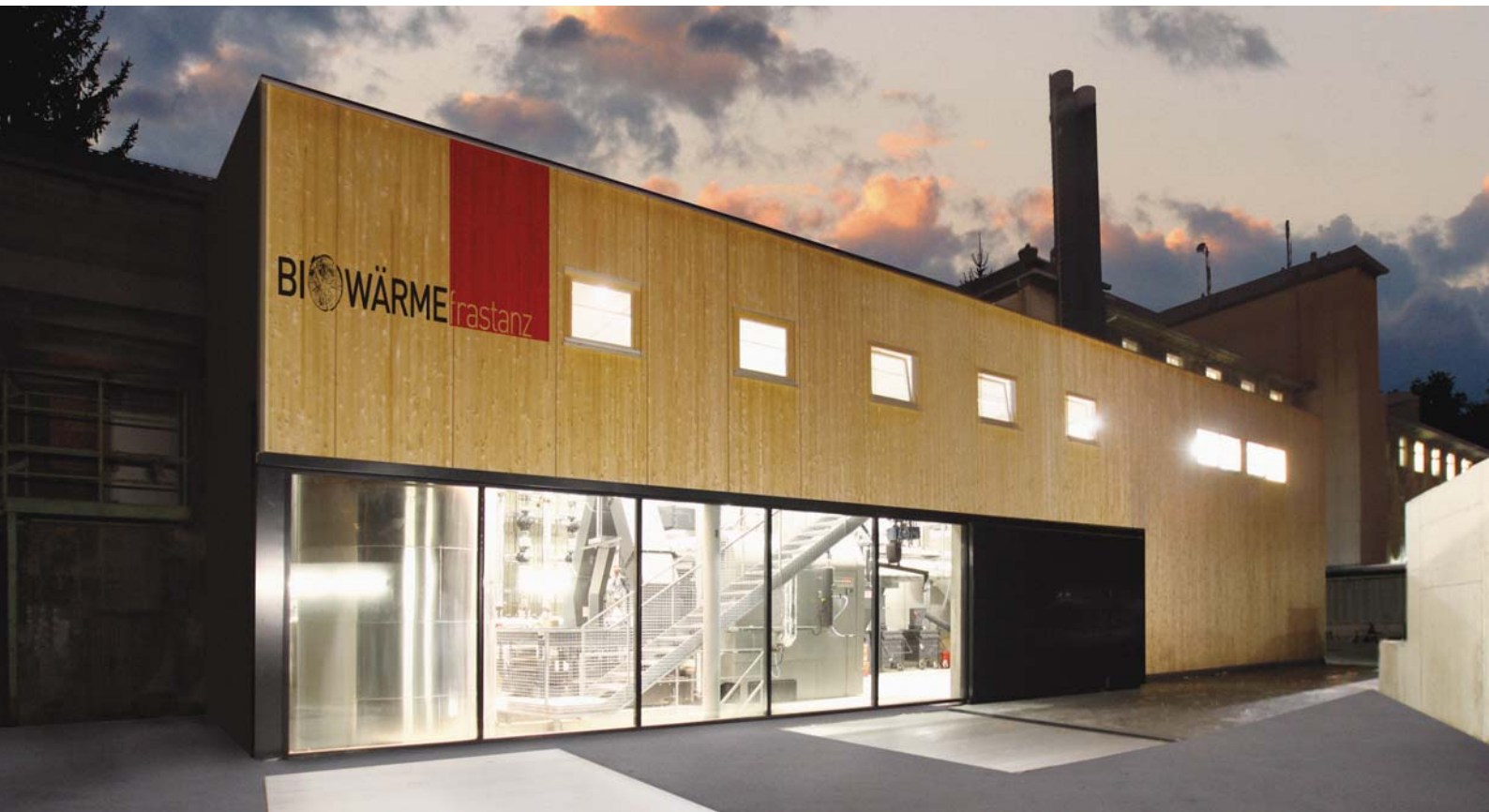
Biowärmezentrale der E-Werke Frastanz, Österreich
