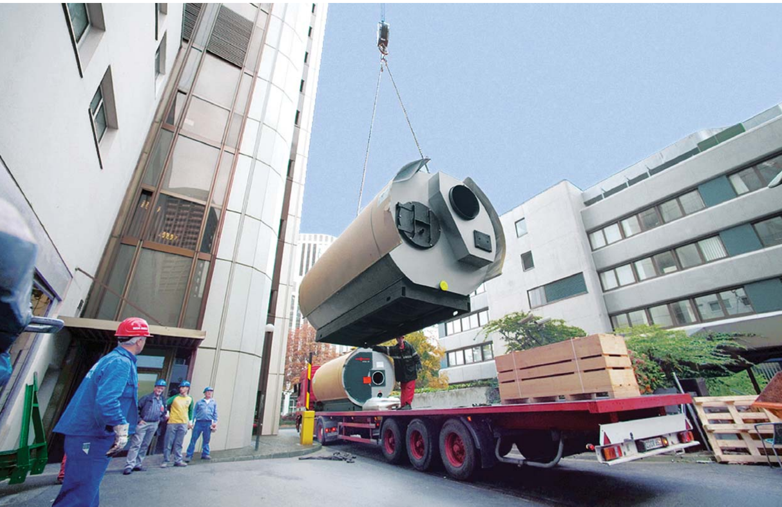
Anlieferung von Viessmann Wärme- erzeugern auf der Baustelle
