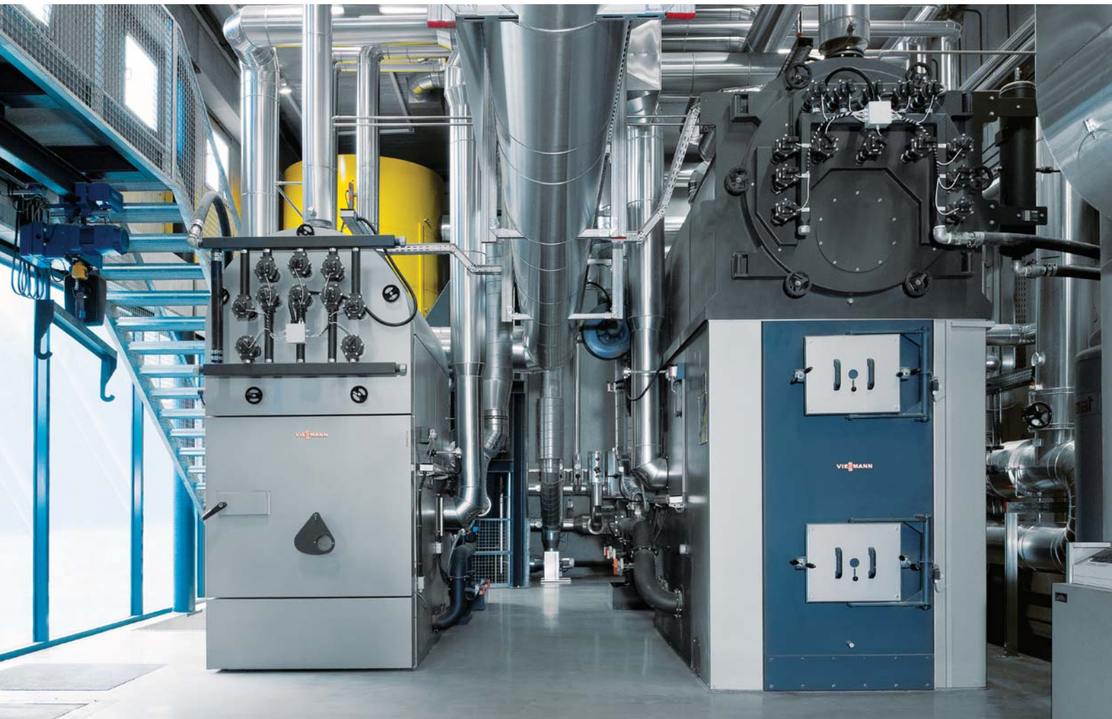
Vitoflex 300-RF – innovativer Holzkessel mit Rotationsfeuerung für Pellets, Hackschnitzel und Holzspäne
