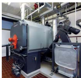
Handelsakademie und -schule, Lustenau in Österreich – Vitoflex 300-RF mit einer Nenn- Wärmeleistung von 220 kW
