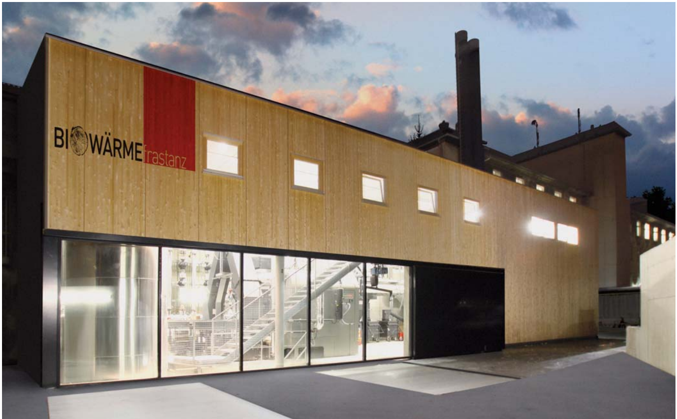
Biowärmezentrale der E-Werke Frastanz, Österreich
