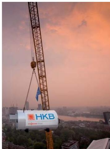
Einbringung eines Kessels über das Dach eines 120 Meter hohen Gebäudes
