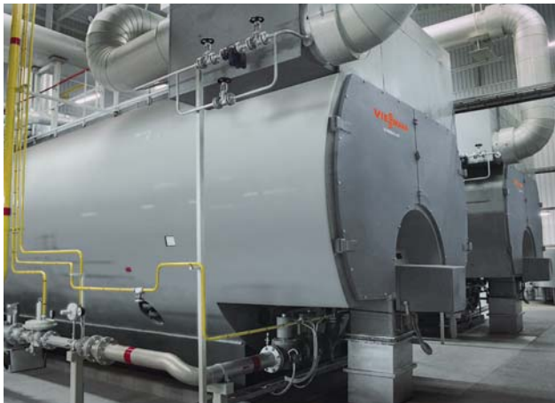
Dampferzeuger mit Überhitzer bei Klaipedos Kartonas, Litauen
