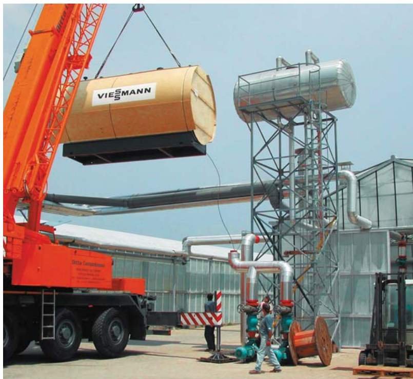
Einbringung des Vitomax mit Kranwagen
