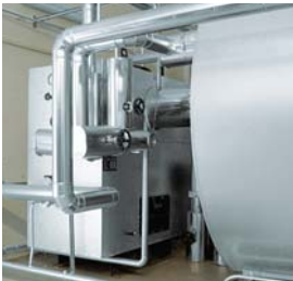
Vitomax HS Dampfkessel mit nachgeschaltetem Economiser
