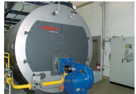
Dampferzeuger bei AZM Asur, Belgien
