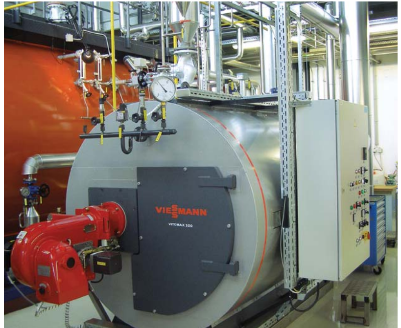
Vitomax 200-HS mit Kessel-ausrüstung
