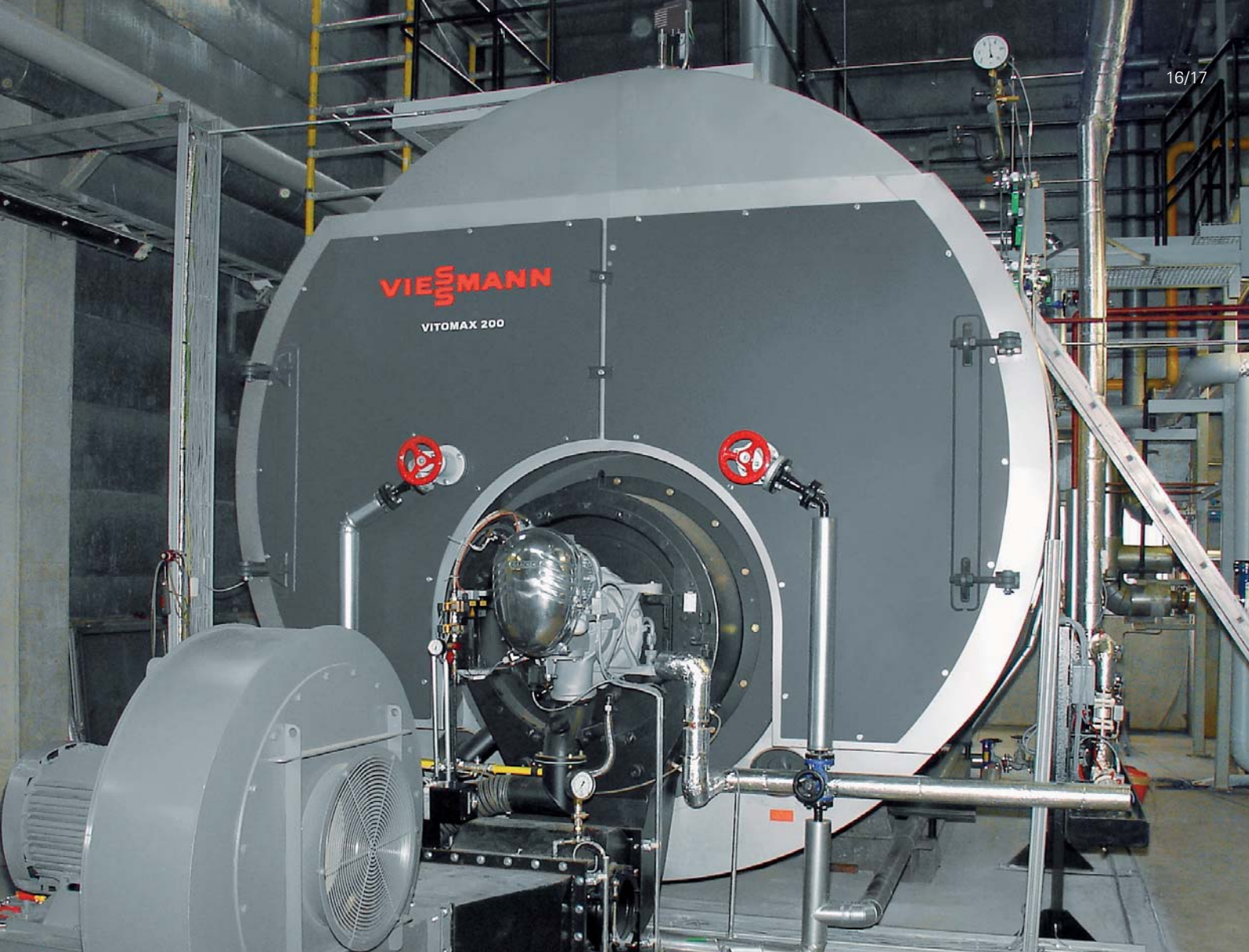
Dampferzeuger Vitomax HS in Sonderausführung für Tierfettverbrennung
