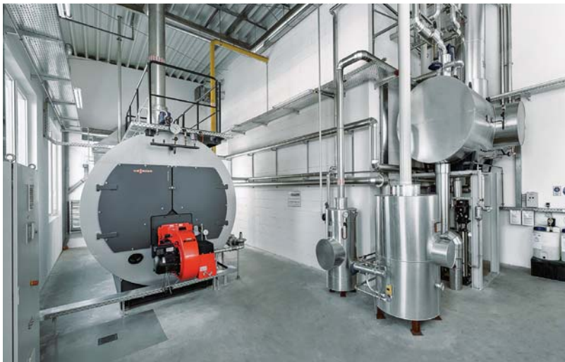
Vitomax 200-HS, 4 t/h, 16 bar StoVerotec, Deutschland
