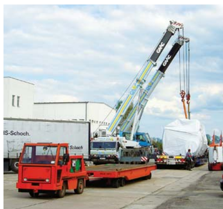
Transport eines Vitomax Kessels
