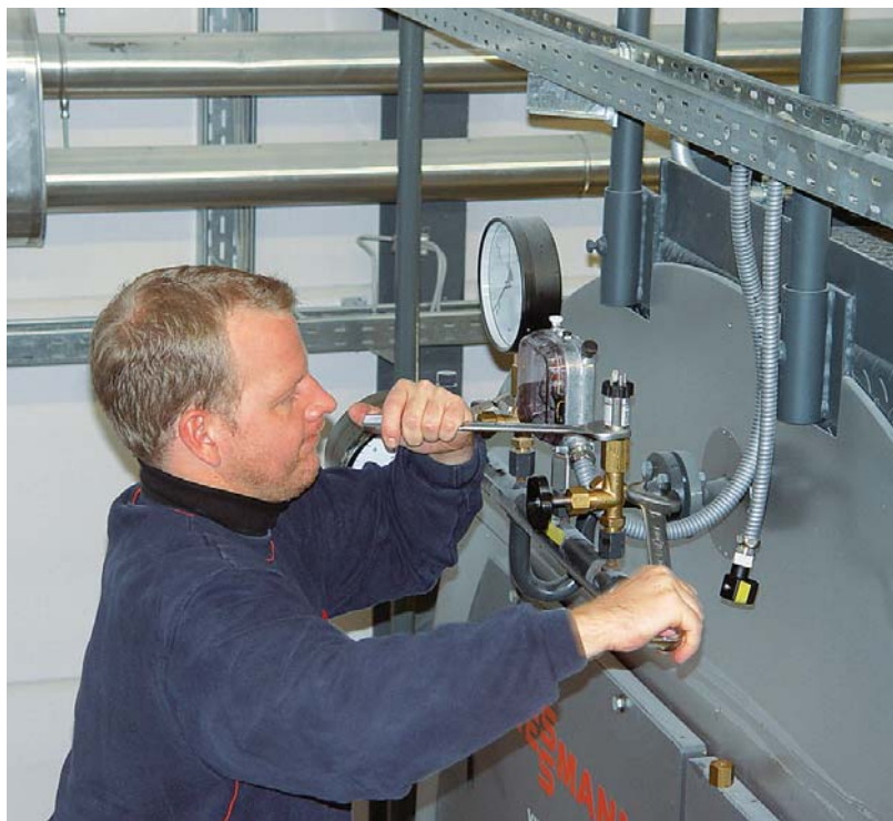
Techniker bei der Wartung
