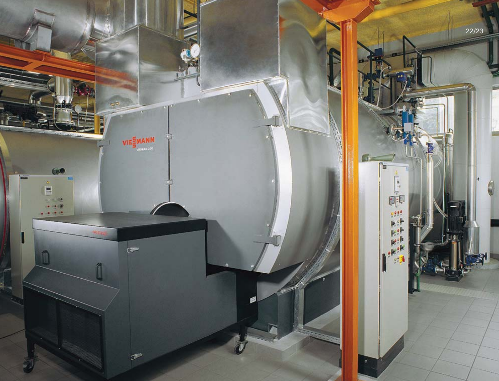
Vitomax 200-RS Dampferzeuger mit Abhitzenutzung im Krankenhaus in Maribor, Slowenien (6 t/h, 13 bar Sattdampf)
