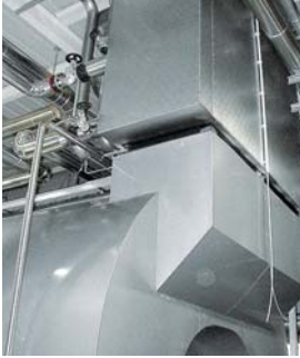
Aufgesetzter Economiser auf einem Vitomax HS
