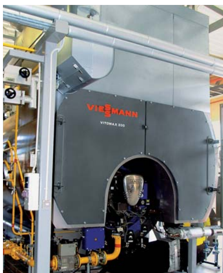
Dampferzeuger Vitomax HS mit Überhitzer
