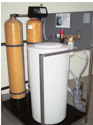
Doppel-Pendel-enthärtungsanlage von Viessmann
