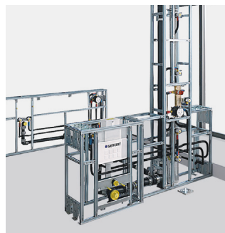
↑ In das fertige Tragsystem werden die Montageelemente integriert und verrohrt.
