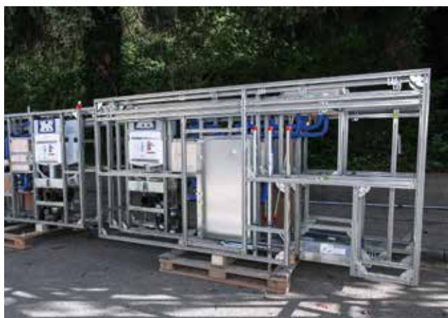
↑ Die vorgefertigten Geberit Quattro Register wurden just in time auf die Baustelle geliefert.
